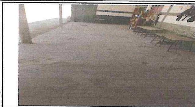
Foto1: Corredor de la Escuela
