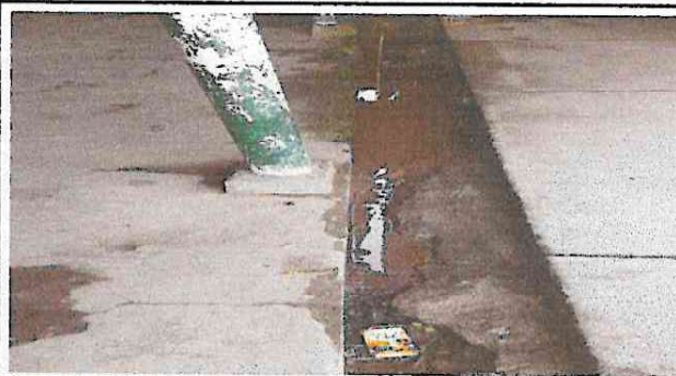
Foto 2: Corredor de la escuela
